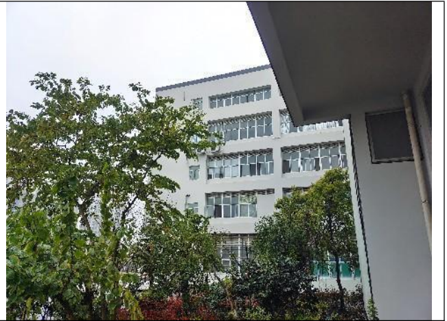
东北侧为温州港城发展有限公司1号楼
